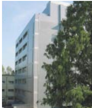
新築になった総合科学棟
